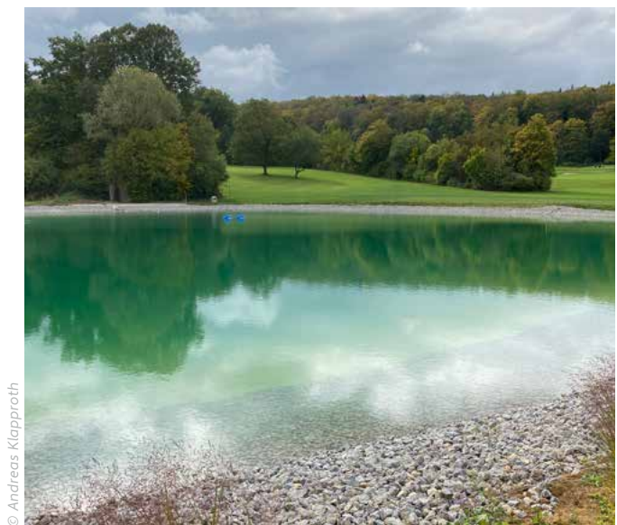
Speicherteich auf der Anlage des Stuttgarter Golf-Club Solitude
