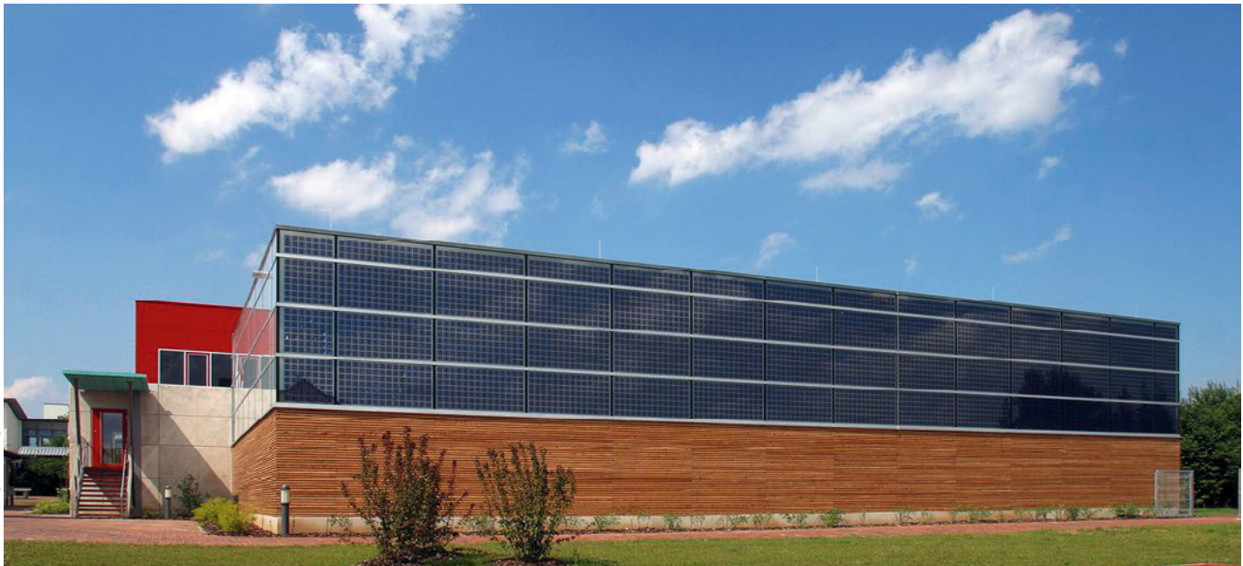
Sporthalle mit Photovoltaik-Fassade in Regensburg
